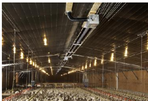
تصویر۶، سیستم گرمایش تابشی لوله‌ای
